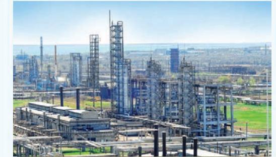
Осуществление мониторинга и управления технологическим процессом с учетом производственных показателей, параметров качества продукции и экономических критериев эффективности. Оптимизация расходов на эксплуатацию и увеличение выпуска продукции промышленных предприятий
